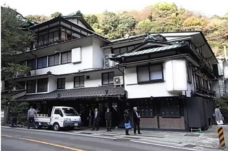
写真1 木造温泉旅館外観（筆者撮影。建物特定防止のため、ケーススタディに影響のない範囲で修正している）
