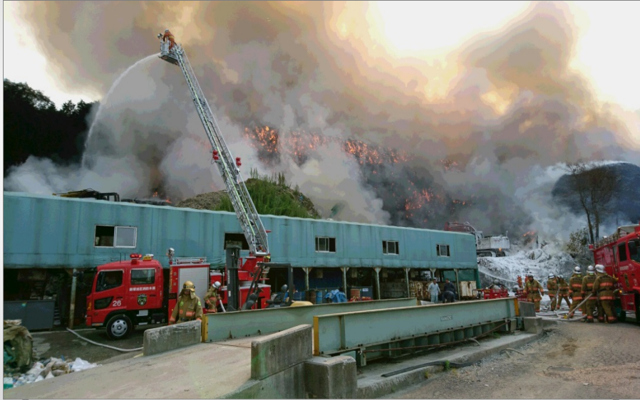
【東側面の燃焼状況と梯子車（15m級）による南東側堆積物消火活動状況】 5月28日
