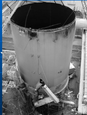
10tの屋根が300m飛ぶ 安全工学, vol50, No. 3, p.174 (2011)
