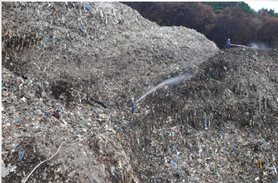
【北東側の堆積物高温部の消火活動状況】 6月20日
