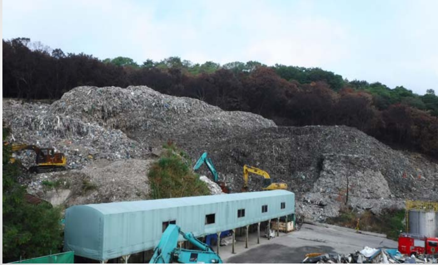
【東側面の焼損堆積物の状況】 6月23日
