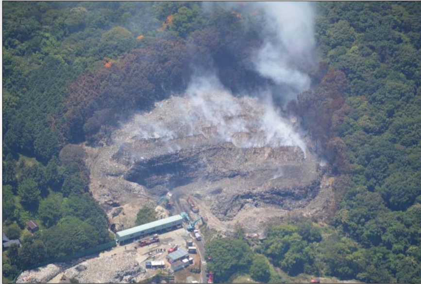
【火災現場上空（北九州市消防局航空隊提供）】 6月2日
