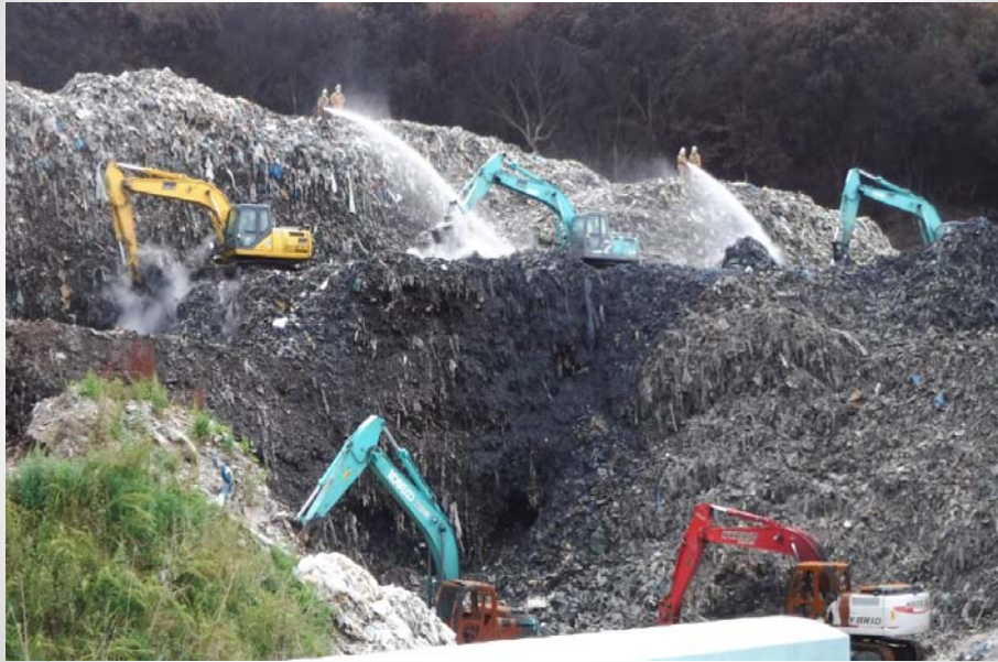
【垂直壁を低く切り崩す放水消火活動】 6月12日
